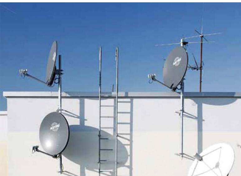
Rund zwei Wochen dauerte die Umrüstung auf eine Glasfaserlösung mit Multischaltern inklusive einer komplett neuen Hausverkabelung. Von den Satellitenspiegeln auf dem Dach des Hauses führen dünne Glasfaserkabel in einen Technikkasten im Keller. Multischalter verteilen das TV-Signal über herkömmliche Koaxialkabel in die einzelnen Wohnungen. Pro Wohnung gibt es zwei Teilnehmeranschlüsse. Im Leistungspaket inbegriffen war ein
